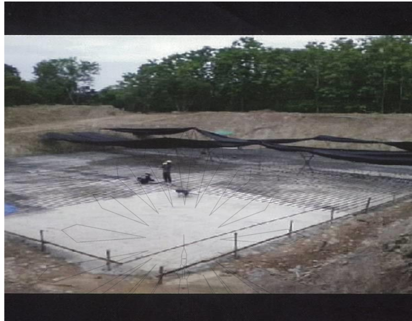
รูปภาพ ภาคผนวก ก ที่ 4 เทรากฐานก่อสร้างเจดีย์พุทธคยาจำลองวัดจองคำ
